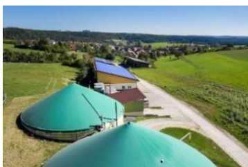
Photovoltaikanlage in der Landwirtschaft in Mauenheim. Foto: Plattform EE BW / Kuhnle & Knödler
