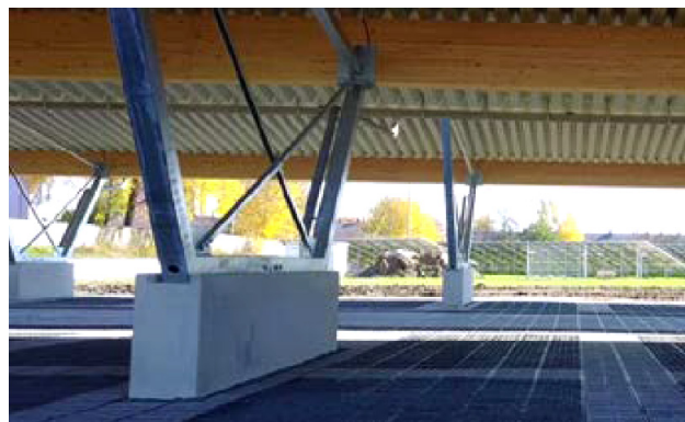
Abbildung 7: Stellplatzüberdachung mit Blechdach, Standardmodulen und großen Fundamenten.
