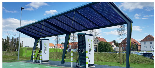
Abbildung 4: Solarer Mobilityhub für Parkplätze und E-Autos: E-Schnellladestationen mit PV-Strom optional mit Informationsdisplay für Bürger, Paketstation, Getränkeautomat, LED-Beleuchtung, Sitzbank, W-LAN Hotspot, usw. – je nach Bedarf. Quelle: Zuwesio GmbH – Für Nachhaltigkeit – www.station-i.de
