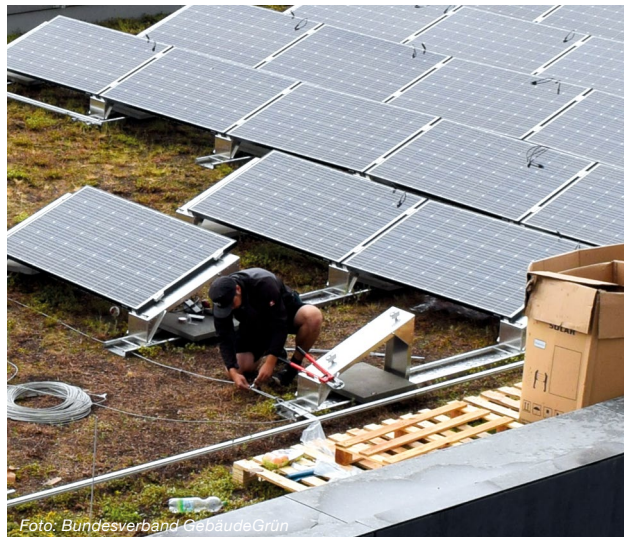
Abbildung 7: Montage einer PV-Anlage auf ein bestehendes Gründach.
