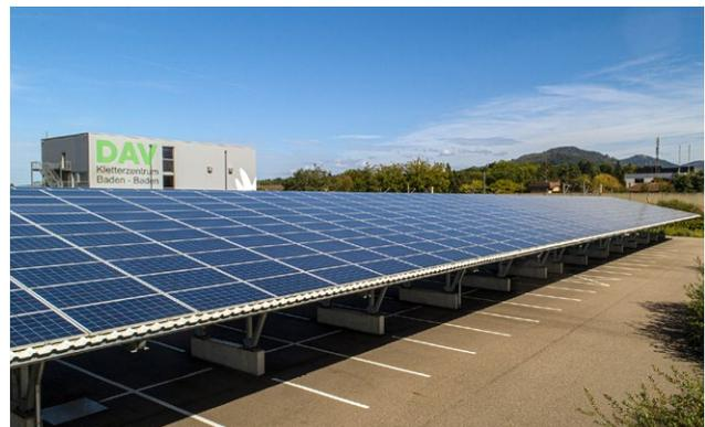
Abbildung 7: Stellplatzüberdachung mit geschlossenem Blechdach, auf dem Standardmodule montiert sind.
