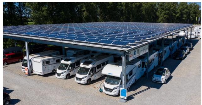
Abbildung 9: Photovoltaik-Stellplatzüberdachung für Wohnmobile.
