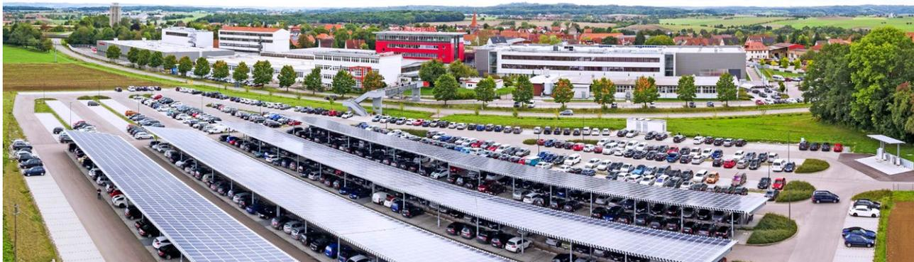
Abbildung 2: Parkplatz für Mitarbeiter\*innen im Landkreis Schwäbisch Hall mit PV-Stellplatzüberdachung. Ausführung mit vier Stützen zwischen den Parkplätzen und Ausrichtung der Module in eine Richtung. Quelle: Bausch+Ströbel Maschinenfabrik
