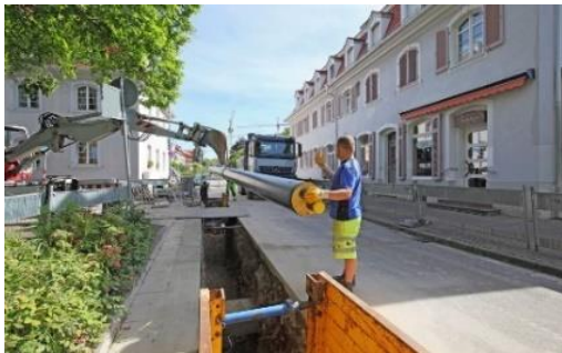
Verlegung eines Wärmenetzes in St. Peter. Foto: KEA-BW / Triolog
