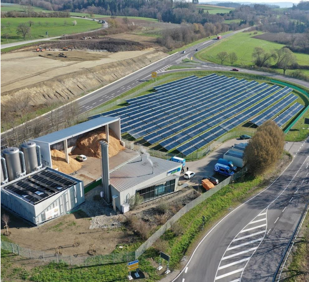
Anlage Überlingen-Schättlisberg, 4.200 qm Bruttokoll.fläche Quelle: Stadtwerke am See
